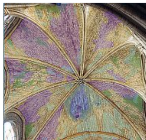
I danni Alterazioni rilevate sulle volte del coro
